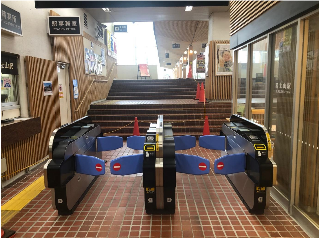
両方向兼用機(きっぷ及び IC カード利用可能) ※ワイドタイプ2通路
